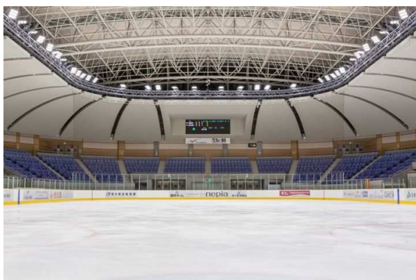
照明設備及び電光掲示板リニューアル工事完成
