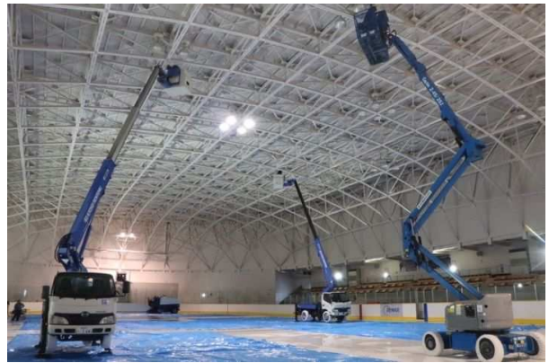
照明設備リニューアル工事
